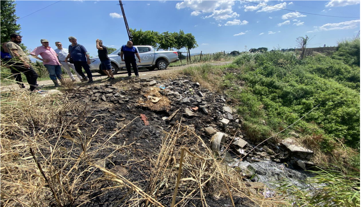
Çoruk Köprüsü Havran Çayına işletme kaynaklı açık kanal deşarj noktası.
