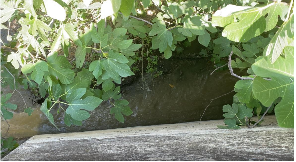
Çoruk Köprüsü civarı Havran Çayına Kanalizasyon deşarj noktası.
