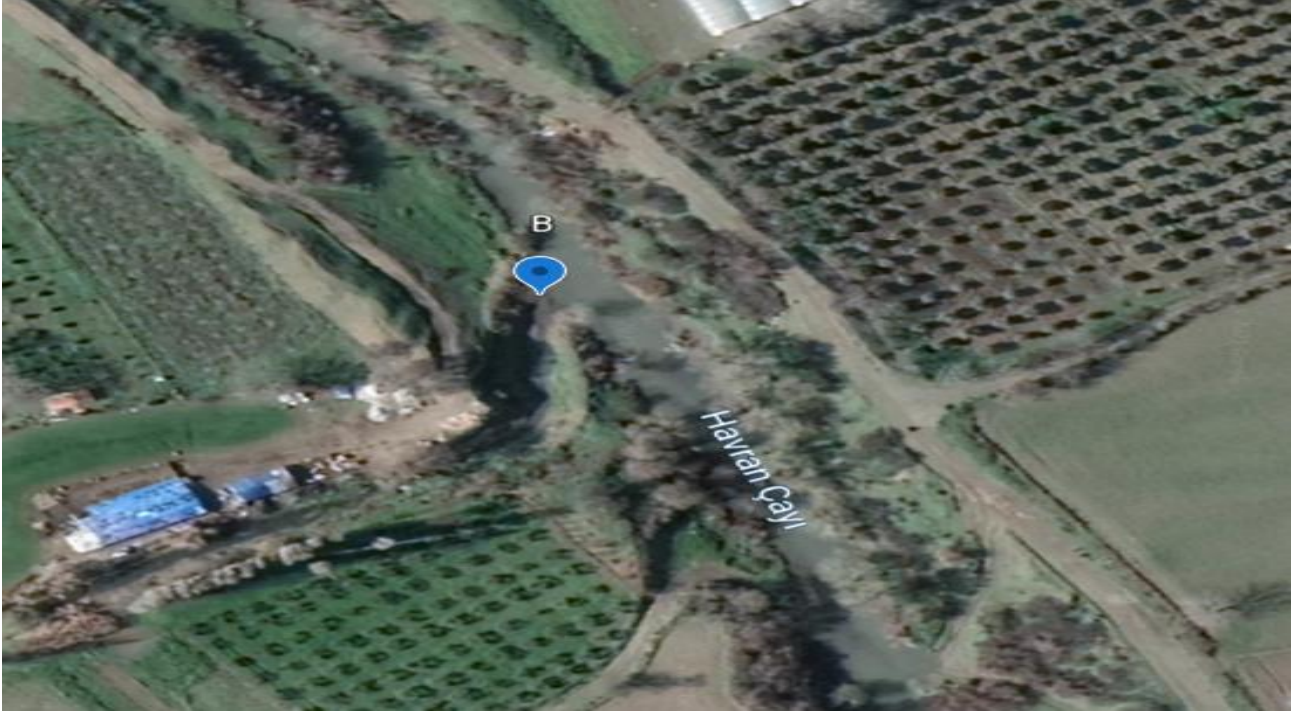
Kızıklı Mahallesi Havran Çayına Kanalizasyon deşarj noktası.
